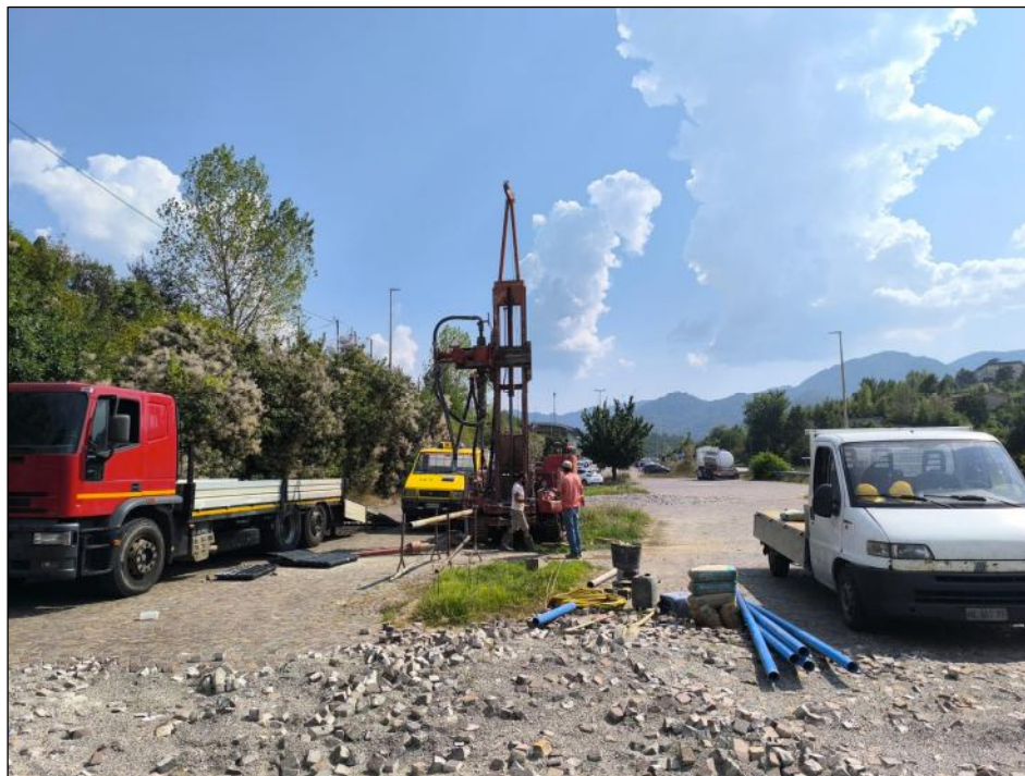
Figura n.20 - Fasi di esecuzione del sondaggio SCC1 realizzato in corrispondenza dell'area in cui verrà realizzata la struttura in progetto.
