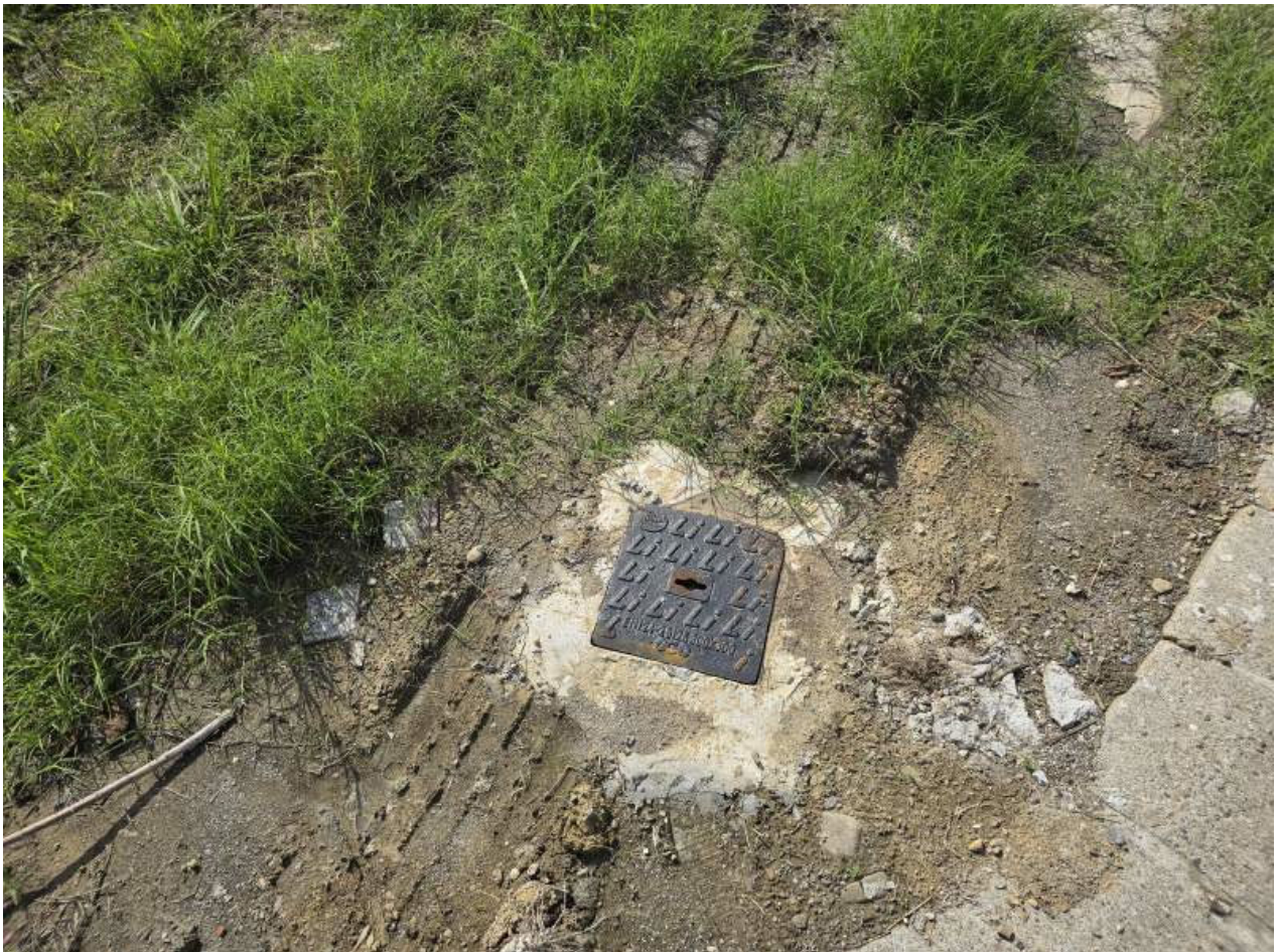
Figura 11_ Dettaglio pozzetto impianto illuminazione
